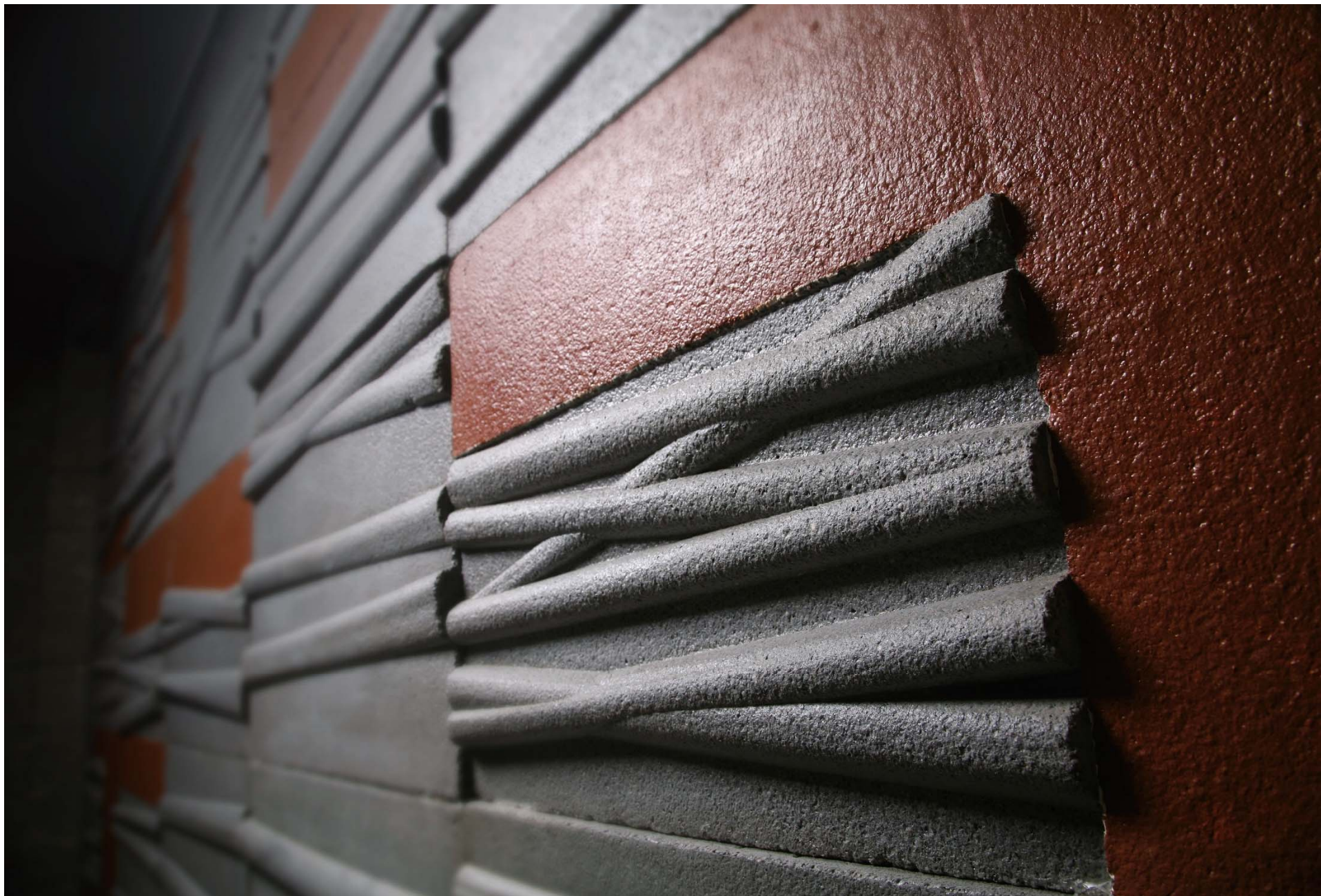
از مجموعه امتداد و رنگ، قطعات بتن و رنگ (دیتیل)، ۲۵۰×۳۵۰، سانتی متر ساختمان اداری سپهر آفریقا، ۱۳۹۱، تهران.
