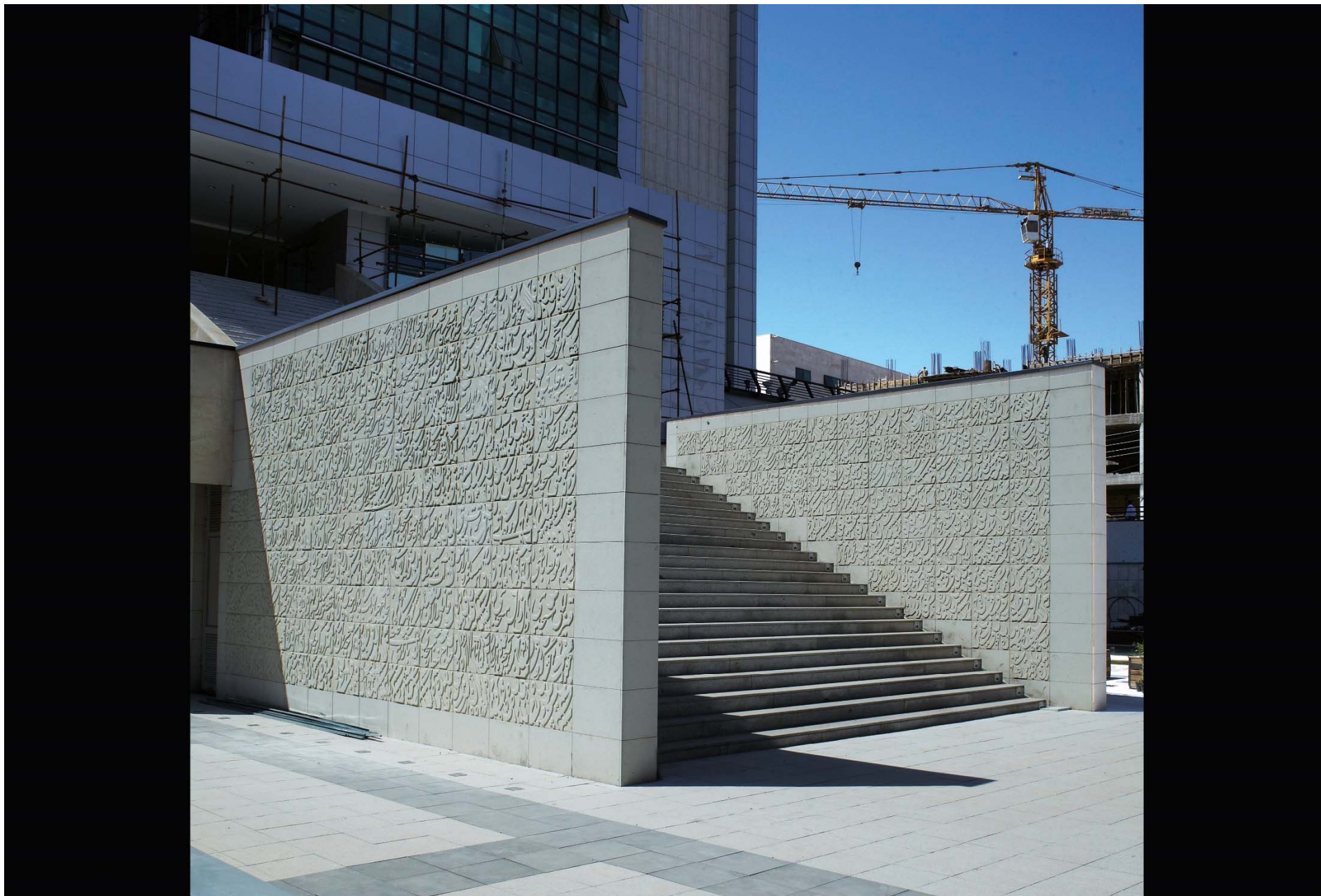
خاطره تبریز، قطعات بتن، ۱۶۵ مترمربع، میدان فرش، ۱۳۹۰، تبریز.
