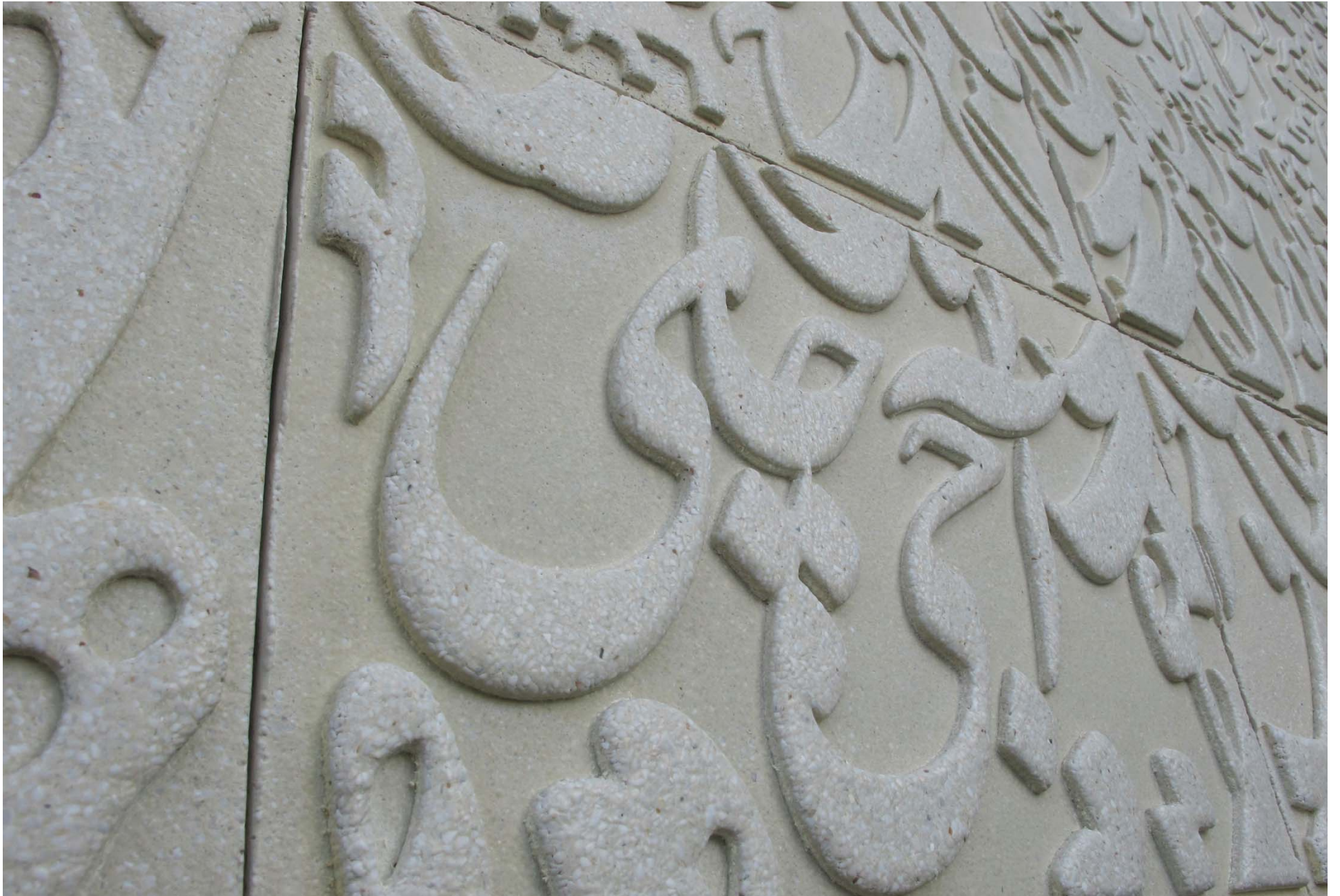
خاطره تبریز، قطعات بتن(دیتیل)، ۱۶۵ مترمربع، میدان فرش، ۱۳۹۰، تبریز.
