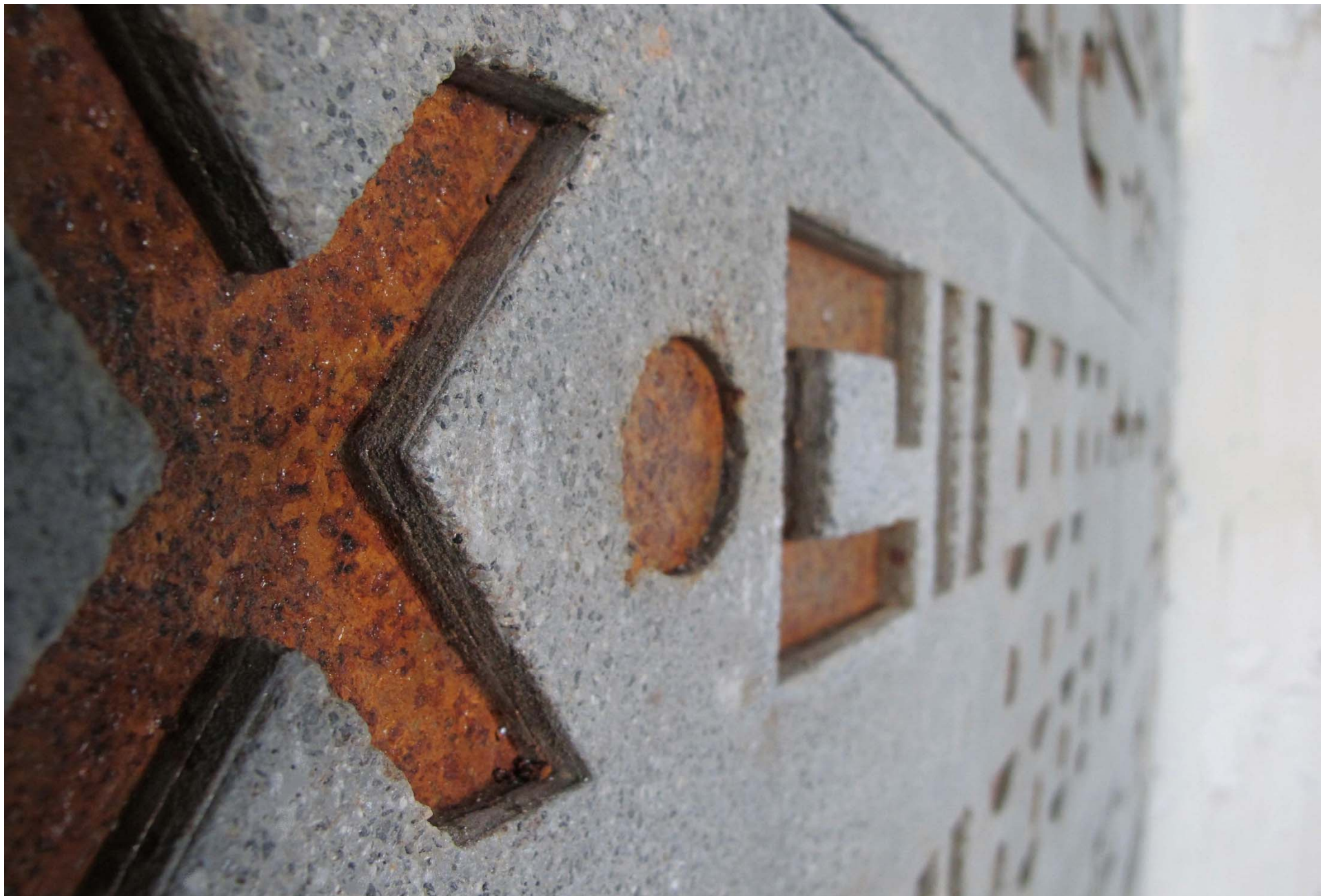
داستان اعداد، قطعات بتن و رنگ (دیتیل)، ۴۰۰×۳۰۰ سانتی متر، ساختمان اداری سپهر آفریقا، ۱۳۹۱، تهران.
